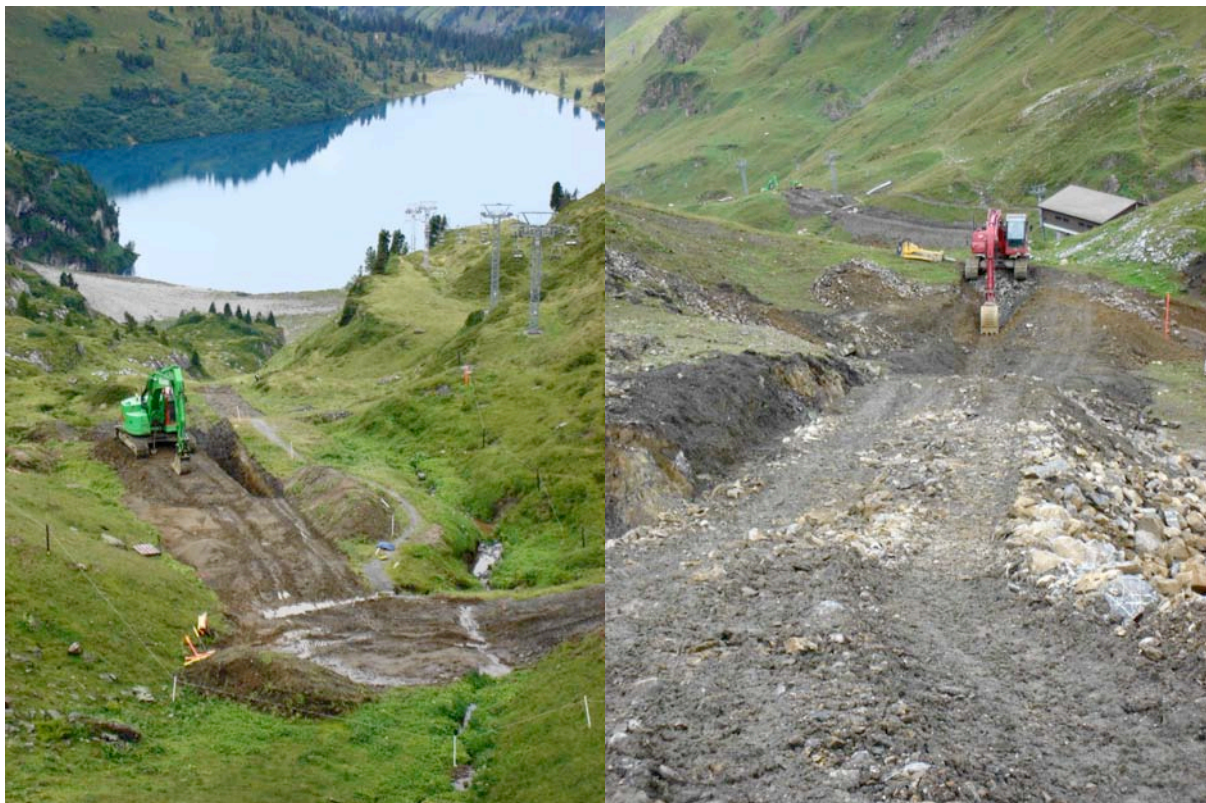
Fotos: Bauarbeiten am Jochpass (August/September 2010)
